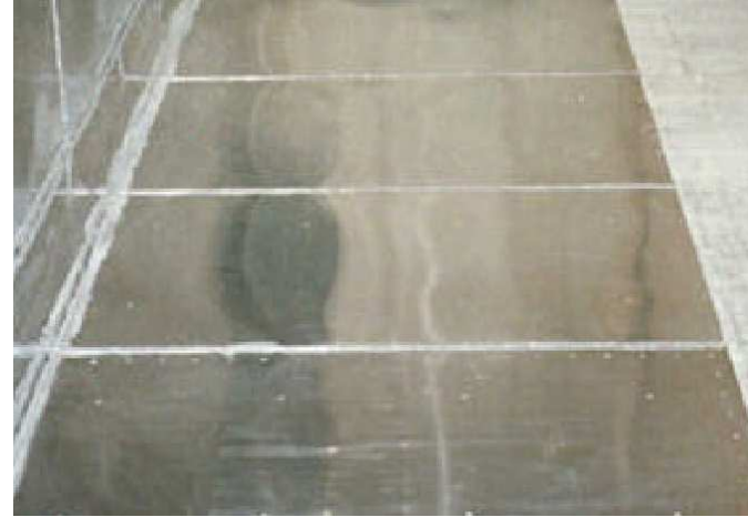
Mu-metal로 만들어진 Aaronia Magnoshield® 로 넓은 지역을 아주 쉽고 빠르게 자기장 스크리닝할 수 있다.
